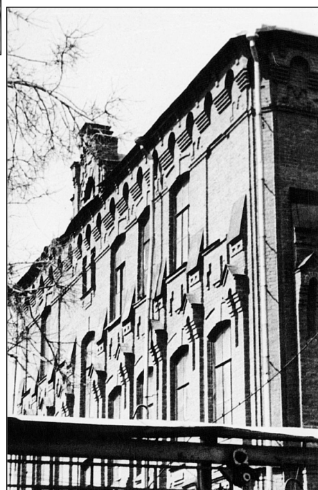
Илл. 4. Склады винной монополии. Фрагмент бокового фасада. 1901.
